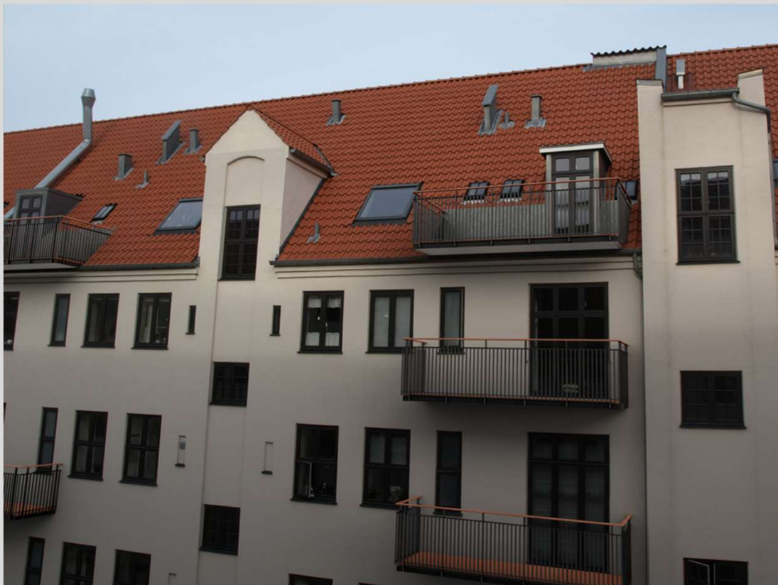
Ekspert i byggeteknisk rådgivning
